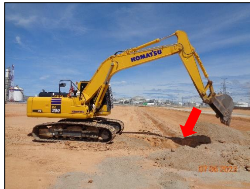
กิจกรรมก่อสร้างรางระบายน้ำภายในพื้นที่โครงการ
